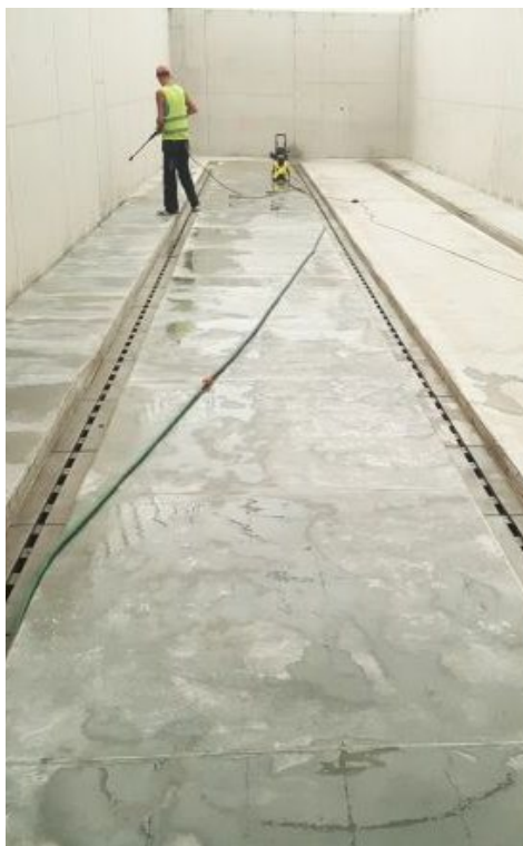
Zakład unieszkodliwiania odpadów Katowice AS-S100 N-0 - 4020 mb
