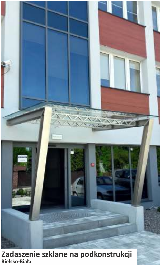
Zadaszenie szklane na podkonstrukcji Lipowa
