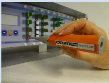
Czyszczenie złącza w urządzeniu
