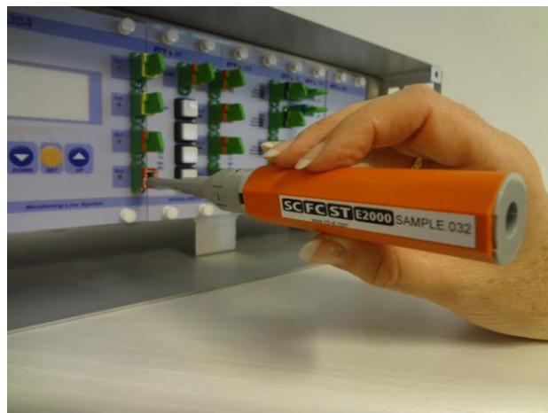
Czyszczenie wtyków E2000/APCw urządzeniu
