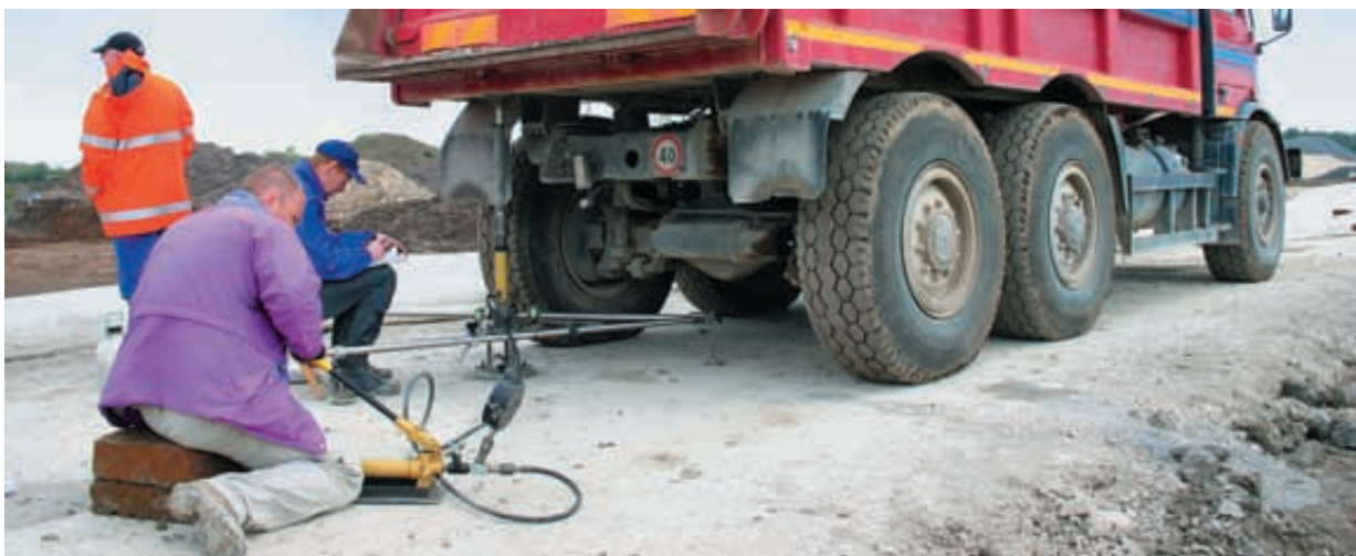
Pomiary płytą obciążaną statycznie VSS z użyciem ciężkiego pojazdu są czasochłonne i nieekonomiczne.
